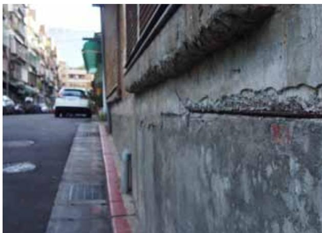
因氯離子侵蝕鋼筋造成腐蝕，影響房屋結構體
